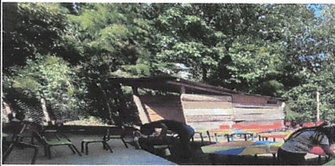
Foto 1. Reparacion de cocina
