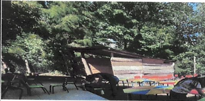
Foto 1. Reparacion de cocina
